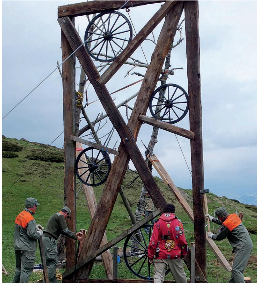
Zivilschützer befestigen eine mit Seilzügen aufgerichtete Holzkonstruktion.
