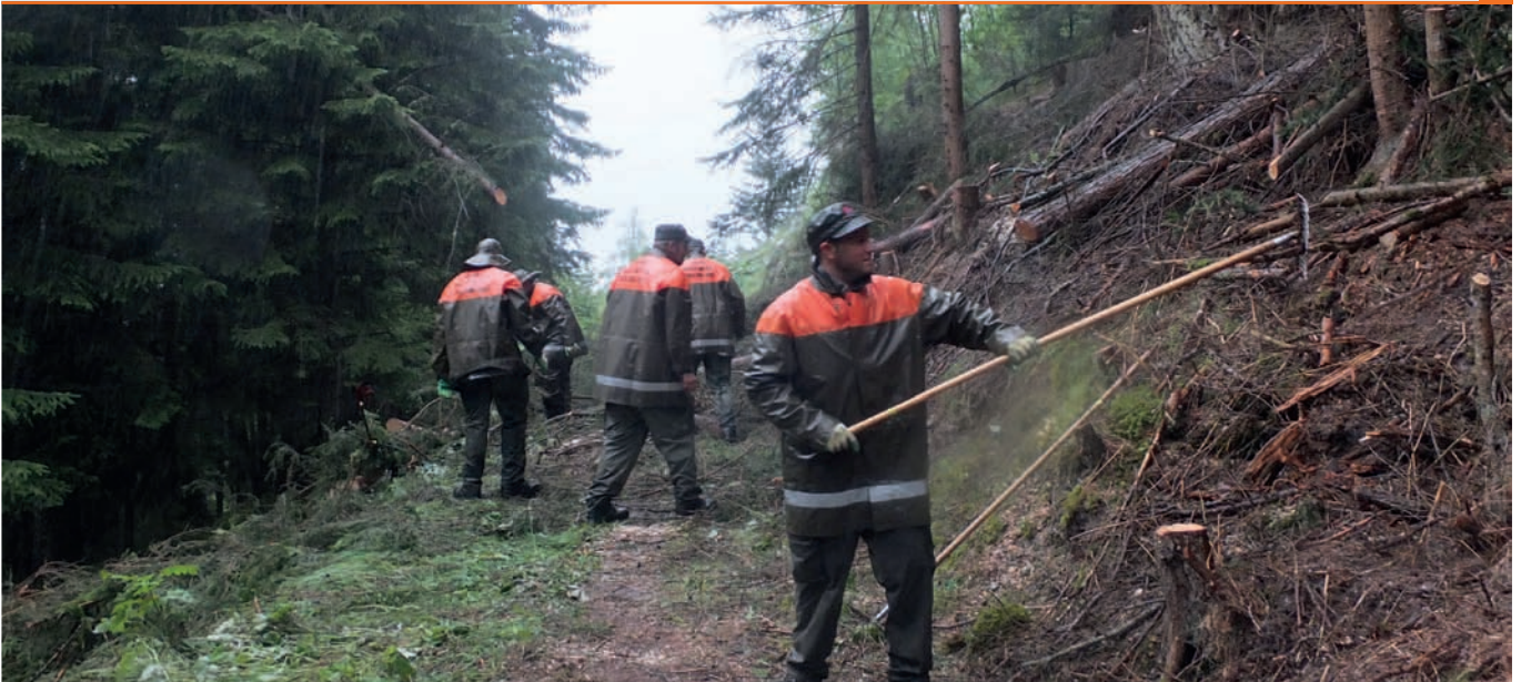
Die Zivilschützer machen einen Waldweg von abgesägten Holzresten frei.
