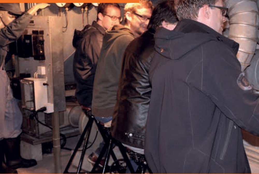
Die Umluftzufuhr kann auch mechanisch mit dem Tretmechanismus vierer Velos betrieben werden. Vier Zivilschützer probieren es aus.
