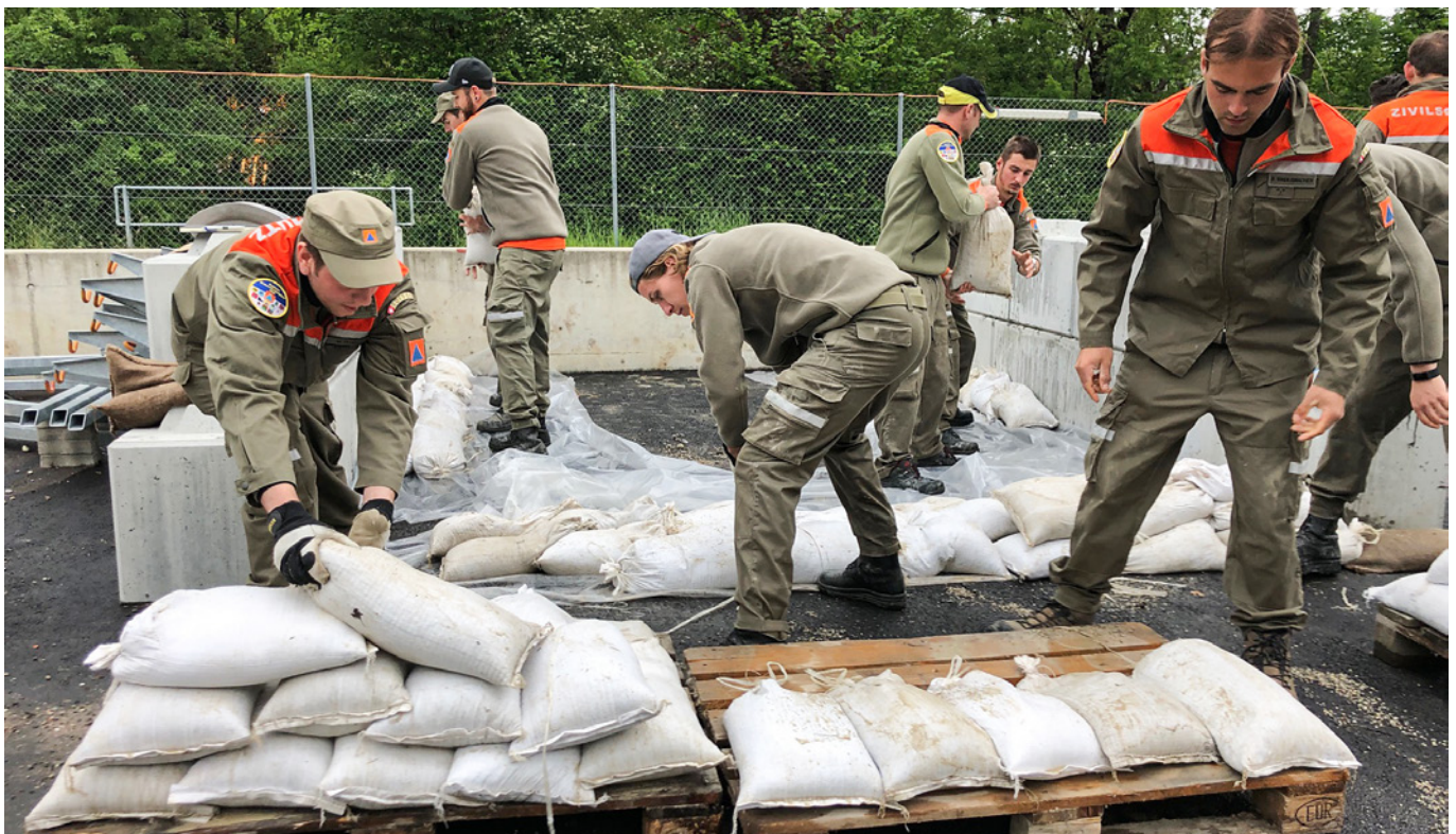
Die Zivilschützer bauen mit Sandsäcken einen Damm auf.
