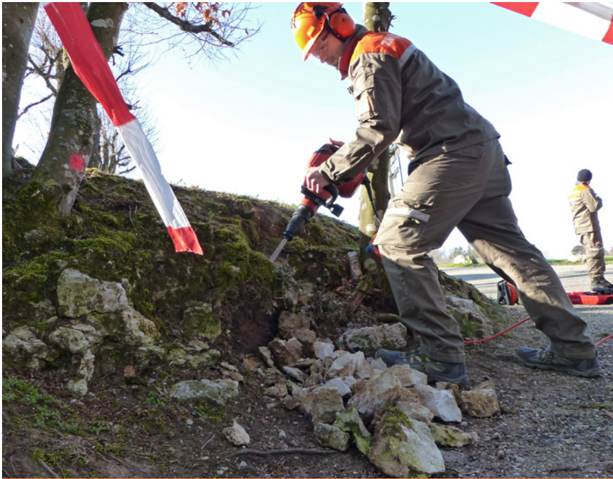
Ein Zivilschützer arbeitet mit Spitzhammer, um ein Loch zu schaffen für die Eichenpfähle.
