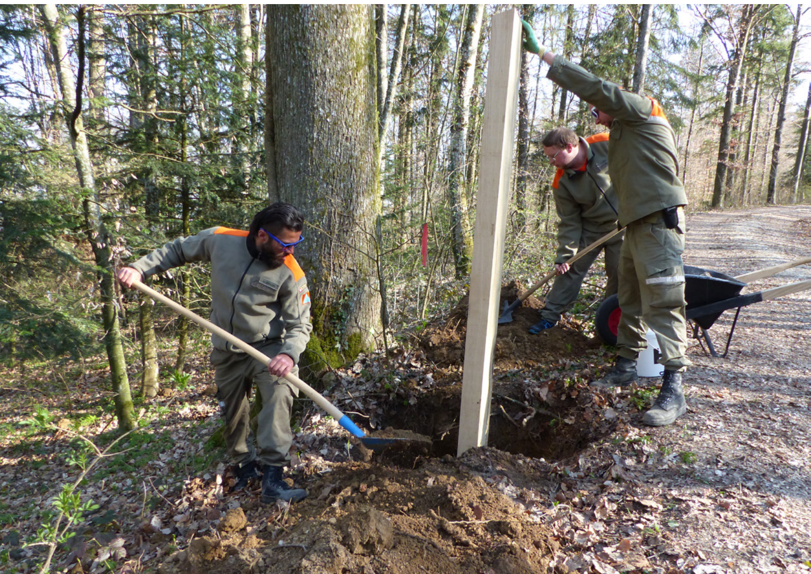
Teamarbeit beim Aufstellen der Stele. Die Zivilschützer haben 60 Eichenpfähle aufgestellt und in den Boden betoniert.
