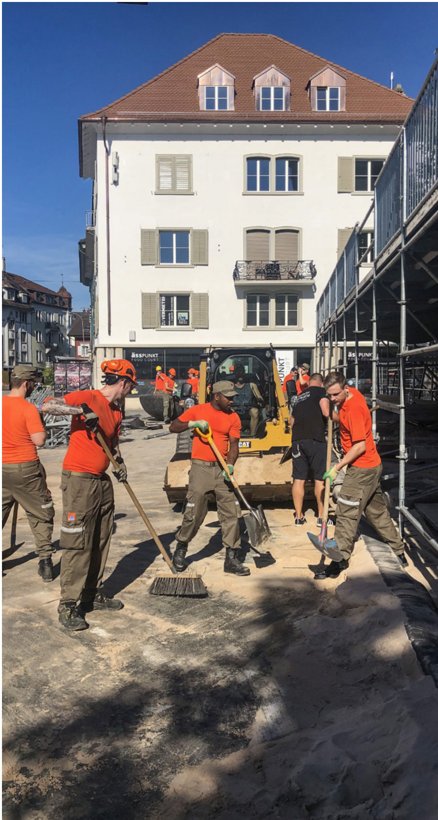
Die Zivilschützer im Einsatz bei den Abbauarbeiten.
