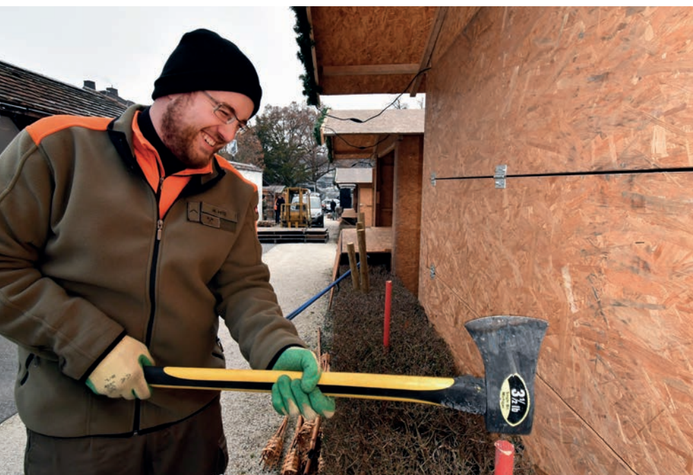
Die Zivilschützer bei der Aufbauarbeit.
