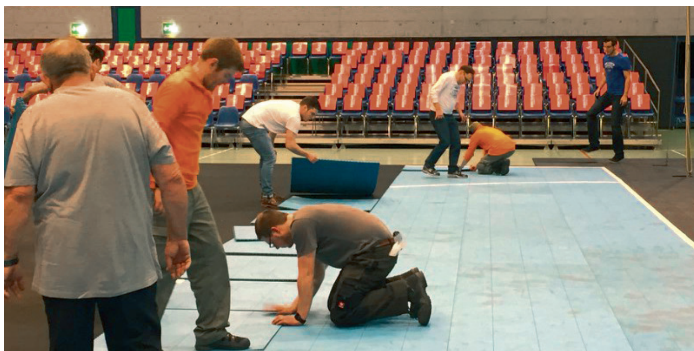
Die Zivilschützer verlegen den speziellen Hallenboden für den Handballoevent.
