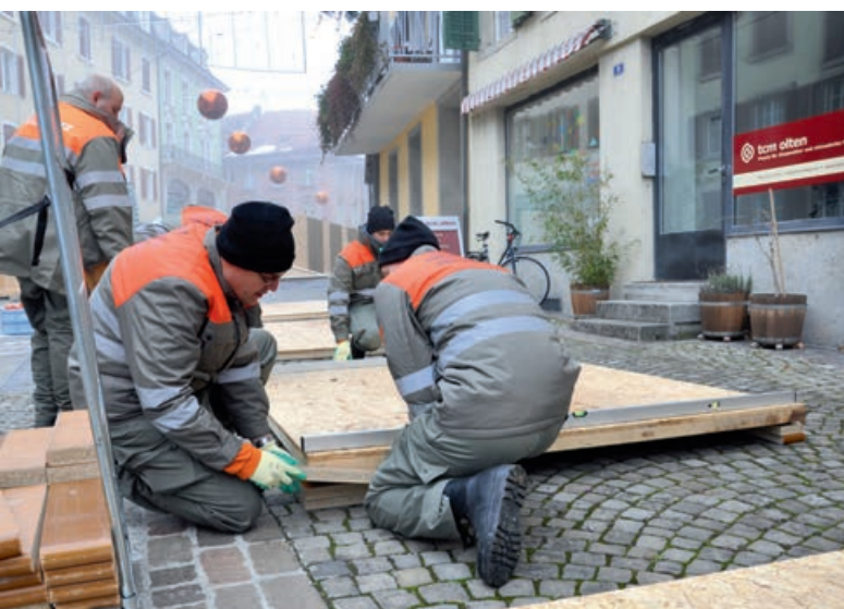
Die Bodenplatte muss eben sein, daher wird sie mit Holzplättli unterlegt.
