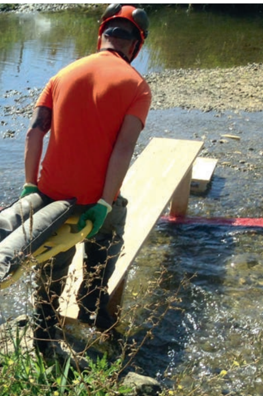
Für das Stauwehr musste das Holz zum Teil mit einer Motorsäge zugeschnitten werden.
