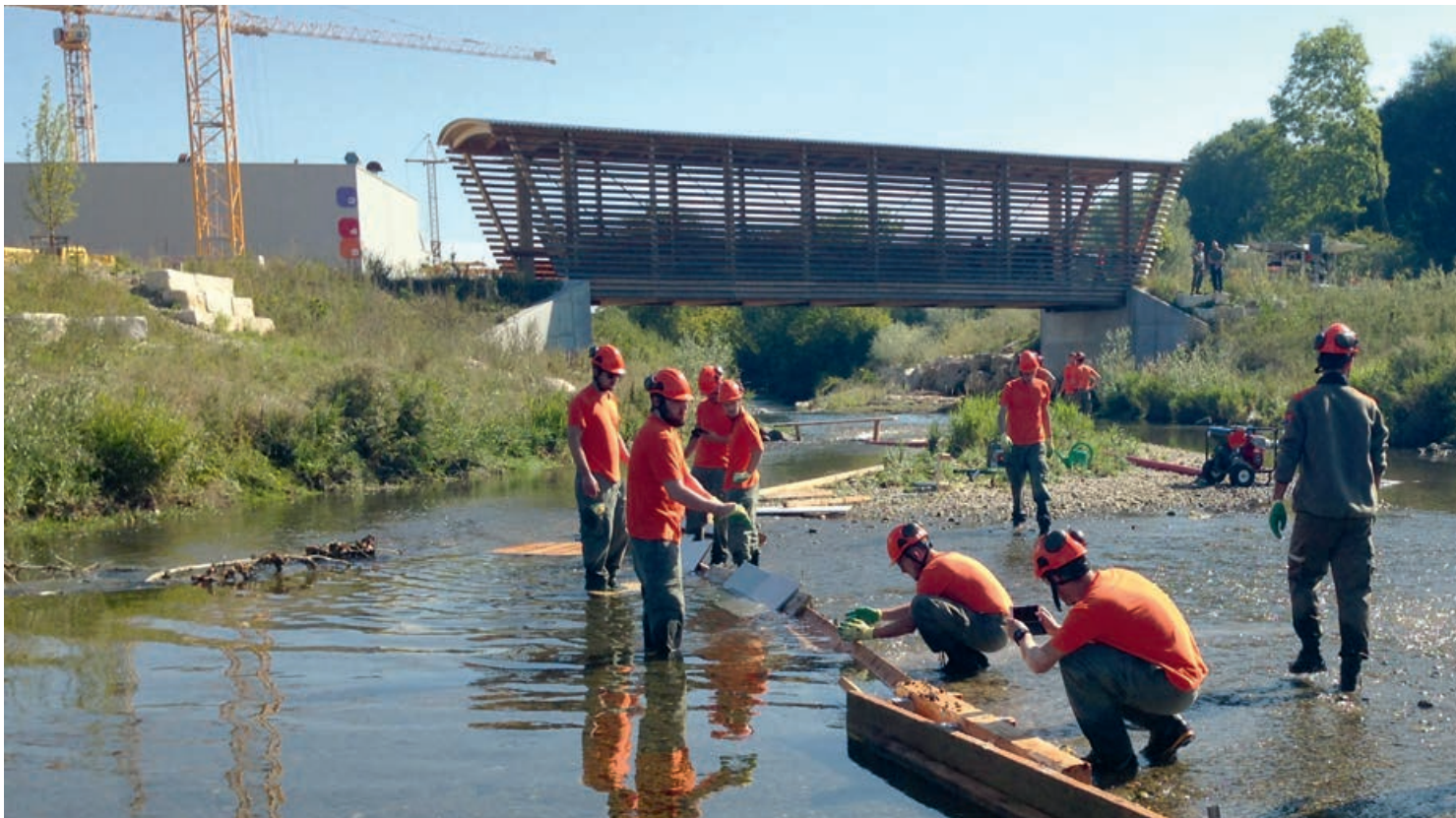
Die Zivilschützer legen ein kleines Stauwehr an, um den Wasserpegel der Dünnern zu senken.
