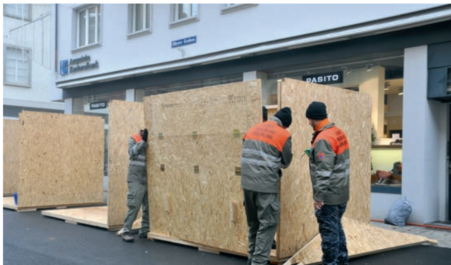
Die Zivilschützer beim Aufbau einer Wandplatte.
