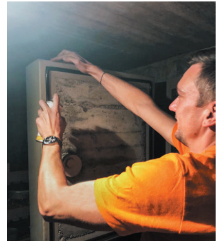
Treuer Begleiter bei der Dichtungsprüfung: Der Silikonspray.
