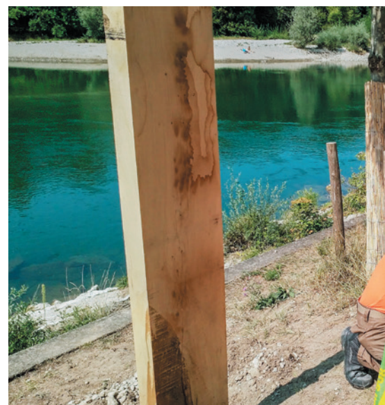
Zivilschützer betonieren eine Eichenstelle (links) ein.
